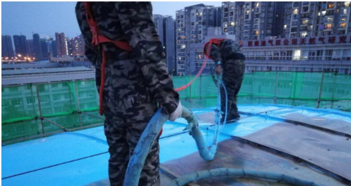
本产品成膜时需要采用特殊专业施工机械喷涂成型，其优异的理化性能指标、便捷的施工工艺、防水防腐系统的整体性，以及环保性是其他任何一种传统防护材料及技术无法企及，对于聚脲防水涂料可以采用两种施工方式：料可刮涂和喷涂成膜，特别是喷涂比较好，聚脲防水涂料采用一次性涂覆工艺，不管有多大面积都不存在链接缝，而且还是种无尘材料聚脲涂料，具有施工简便，快速固化的优点。聚脲防水涂料的应用为美化城市环境、改善生活质量，屋顶花园、城市广场景观绿化等环境工程提供了良好的支撑。采用聚脲能有效防止植物根系的生长刺穿，杜绝
